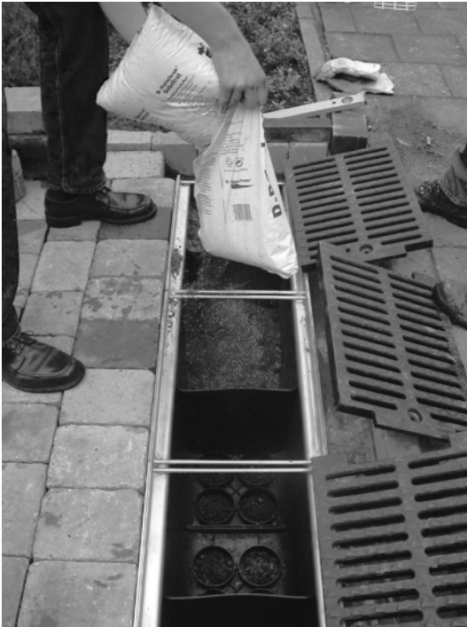
Abbildung 3: Die mit der GaLaBau-Innovationsmedaille ausgezeichnete Sickermulde D-Rainclean der Funke Kunststoffe GmbH. Das System besteht aus 50 cm langen, 30 cm breiten und rund 40 cm hohen Kunststoffelementen, die mit einem Substrat gefüllt werden. Das Spezialsubstrat, vom Bodenökologischen Labor Lemwerder entwickelt, kann auch Schwermetalle wie Cadmium, Blei oder Zink durch einen physikalischen Vorgang einlagern. So wird das Grundwasser über einen langen Zeitraum geschützt. Je nach Belastungsgrad erreicht D-Rainclean laut Herstellerangaben Standzeiten von 15 bis 20 Jahren. Danach wird der Austausch des Substrates empfohlen. Foto: Funke
