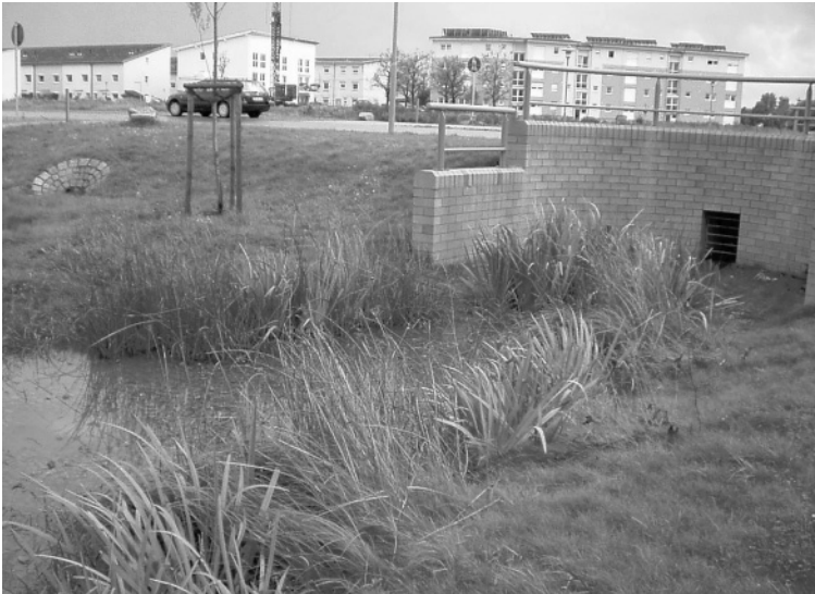
Abbildung 1: Die Installation von Versickerungsanlagen ist in vielen Fällen auch bei Sanierungen möglich, wie der Martin-Luther-King-Park in Mainz zeigt. Das ehemalige amerikanische Wohngebiet wurde im Rahmen eines europäischen Wettbewerbs in ein modernes Gartenstadtquartier umgebaut. Um das Wohnumfeld zu verbessern, entwickelte das Planungsbüro Adler & Olesch, Nürnberg, ein ganzheitliches Entwässerungskonzept, mit dem fast das gesamte Niederschlagswasser dezentral zurückgehalten und versickert wird. Die Voraussetzung bietet eine oberflächennahe Entwässerung durch Rinnensysteme, an die sich Versickerungsanlagen jeder Art anschließen lassen. Foto: ACO.
