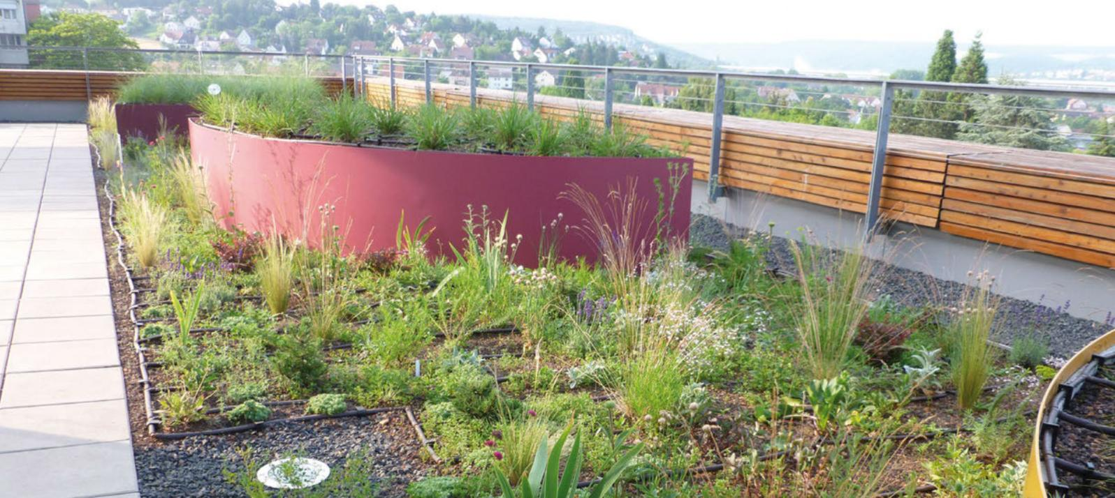
Bild 1: Tropfbewässerung auf dem Dach des Laborgebäudes an der Bayerischen Landesanstalt für Weinbau und Gartenbau, Veitshöchheim
